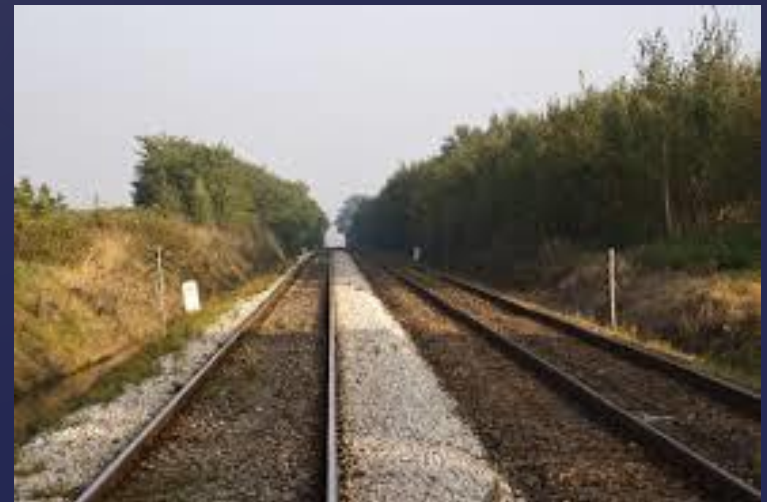
Linia kolejowa w przekopie z rowami odwadniającymi
